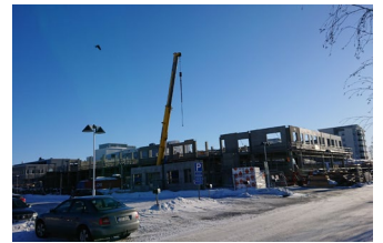
新築移転工事中のケロプダス病院 (西ラップランド地方)
